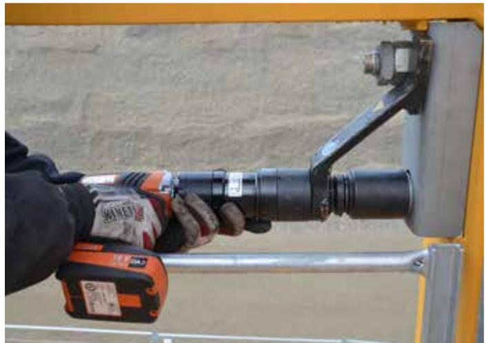
Waren früher nur hydraulische Werkzeuge von Liebherr für die Kranmontage zugelassen, haben mit der aktuellen Ti (Technische Information von Liebherr) nun auch elektrische und akkubetriebene Drehschrauber die offizielle Zulassung von Liebherr für die Kranmontage erhalten. Durch aufwendige Tests wurden im Vorfeld verschiedene Schrauberfabrikate auf Herz und Nieren geprüft.
